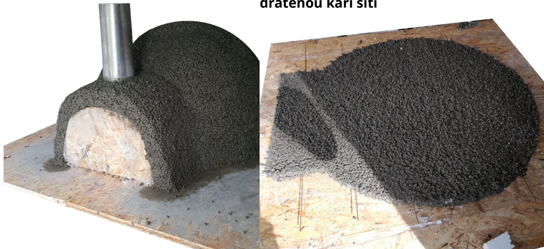
(2) - Podstavec pece proložený drátěnou kari sítí
